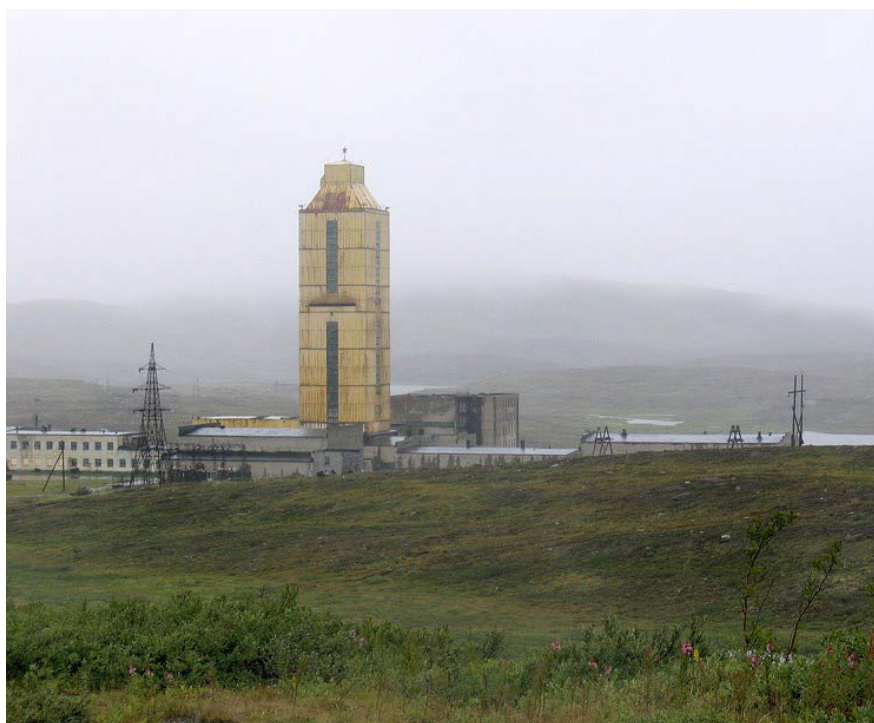
Figura 2 - Fotografias do prédio que abriga o equipamento e o pessoal envolvido na perfuração do poço mais profundo do mundo, na península de Kola, na antiga União Soviética. Na torre que se destaca com a altura de um prédio de 30 andares está o sistema de ponte rolante para a montagem e a desmontagem do conjunto de perfuração (KOZLOVSKY, Ye. A. The world's deepest well . Scientific American, dezembro 1984, e KERR, Richard A. Deep Holes Yielding Geoscience Surprises . Science vol. 245, 4 agosto 1989).
