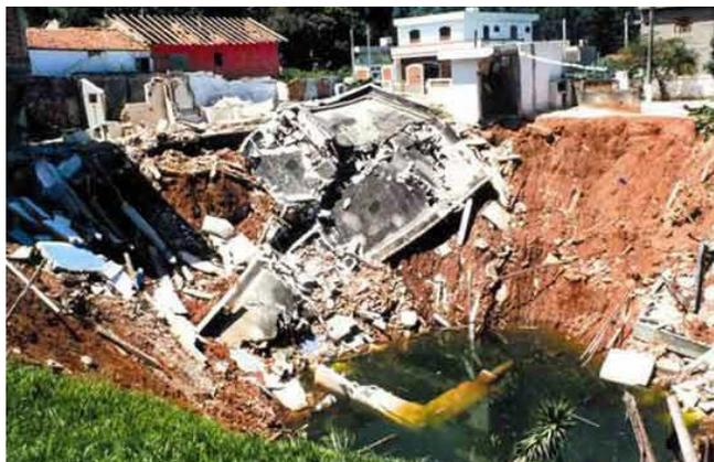
Figura 5 – Exemplo de formação de uma dolina de colapso em Cajamar (Estado de São Paulo, em 1986. Observe-se o afundamento ocorrido no local.)
