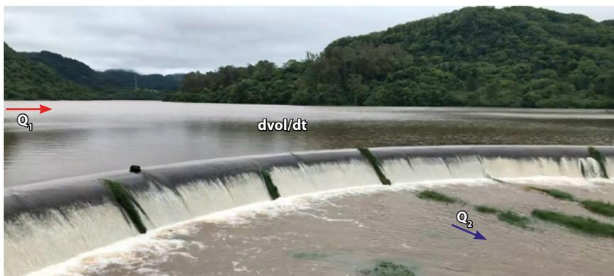
**ESQUEMA ILUSTRATIVO DO BALANÇO DE VAZÕES EM UM RESERVATÓRIO DE ACUMULAÇÃO**
